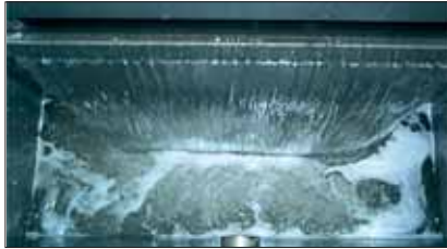
Eau clarifiée de retour vers la fosse.
